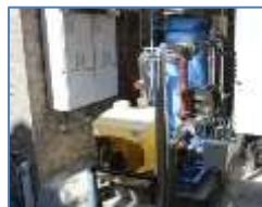
給水ポンプ付近へ
